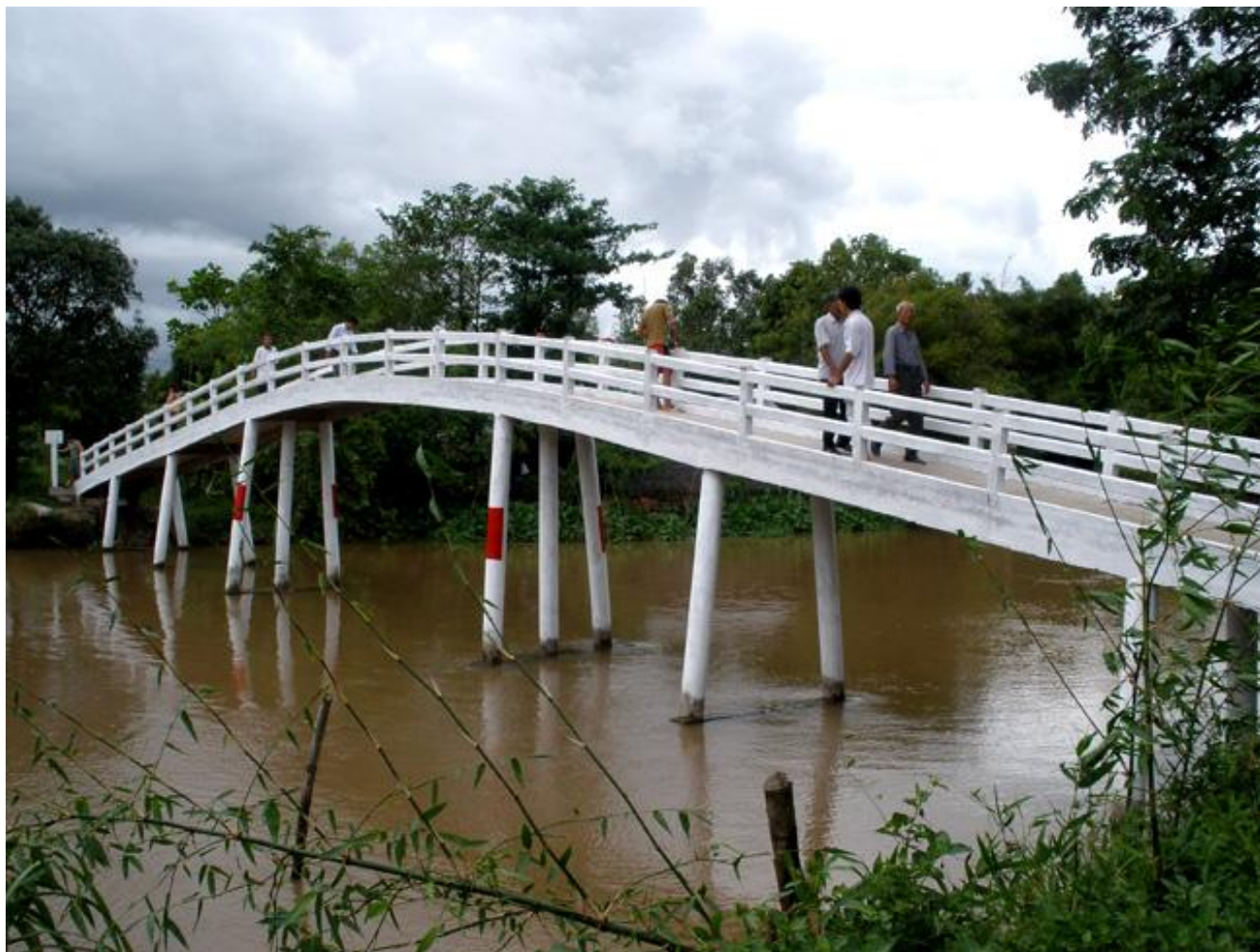
Pont en béton au village Dinh Hoa, district Lai Dung, province Dong Thap
